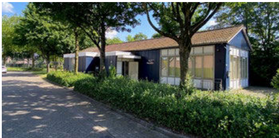
Wijkgebouw Op 't Nipperke is aan vernieuwing toe.
